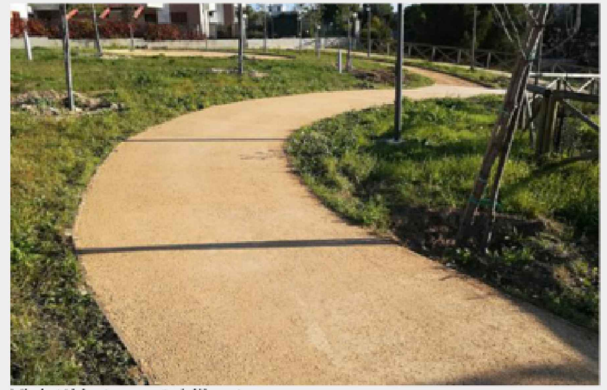
Vialetti in terra stabilizzata
